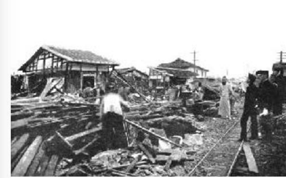
嘉義(嘉義市政府)前大馬路二側倒潰的民宅，散落的磚瓦已分不清道路位置，潰損倒塌的家屋加設支柱支撐。
